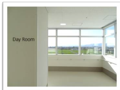
デイルーム 壁の面積を少なくし全面に窓を設置することで開放的な空間にしました。
