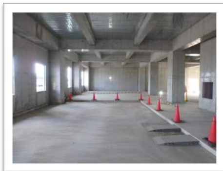
1階の型枠解体作業が完了しました。この場所は、エントランスホールから総合受付をみた写真です。
