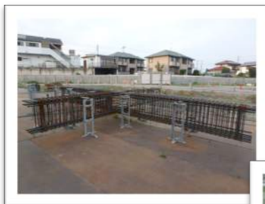
→スラブ配筋と段差枠を組み立て、コンクリート打設の準備を行っています。
