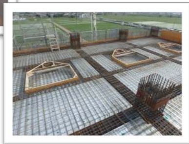
→スラブ配筋と段差枠を組み立て、コンクリート打設の準備を行っています。
