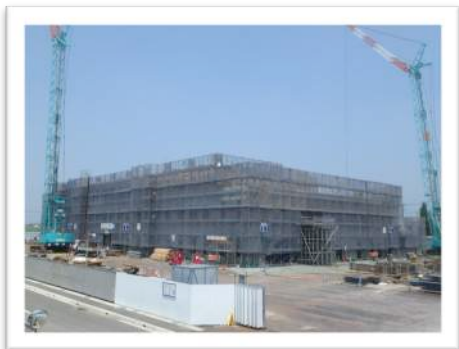
7月10日撮影。現場事務所（南東）から見た、3階の躯体施工状況です。
