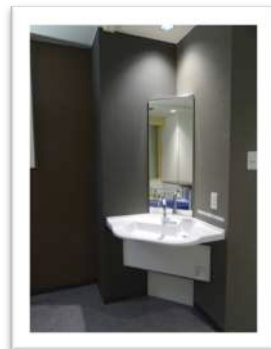
個室病床のモックアップ一部。角を利用することで無駄なくスペースを使えるように工夫しています。
